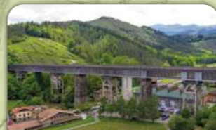
1 Ormaiztegi zubia Viaducto de Ormaiztegi
